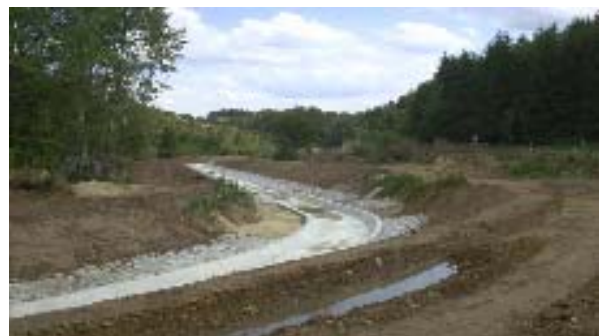
Elegant und nahezu Unauffällig wurde das Betongerinne dem natürlichen Geländeverlauf angepasst
