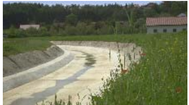
Im zweiten Bauabschnitt wurde der neue Kanal in das vorhandene 700 m lange marode Gerinne verlegt
