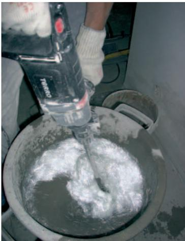
Die eingerührten Fasern beeinträchtigen die Verarbeitungseigenschaften in keiner Weise, auch nicht in höherer Konzentration. Vor allem bleiben Konsistenz und Nivellierfähigkeit erhalten. So können mit dem faserverstärkten Material ebenso sicher hervorragend glatte Oberflächen erreicht werden wie ohne Fasern.
