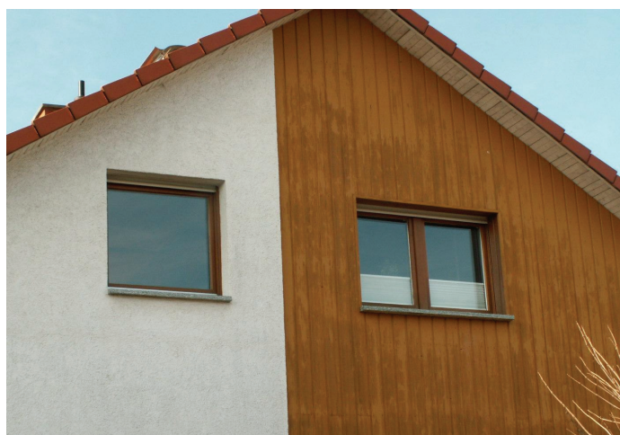
Bild 2. Giebelwand des Wohnhauses zur Straßenseite ohne wesentliche Beanstandung
