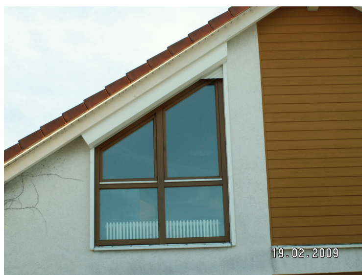
Bild 3. Ausschnitt der Giebelwand des Wohnhauses zur Gartenseite mit Wärmeverlusten im Bereich des Jalousiekastens
