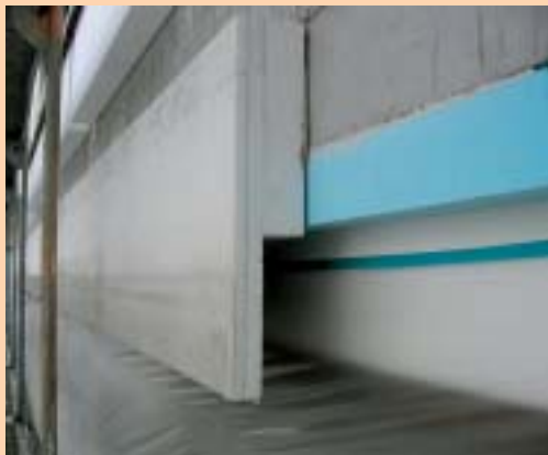
7 + 8 Versetzte Schürzenelemente bei einem Neubau und die Darstellung des Konstruktionsaufbaus. (Fotos: Maxit Deutschland)
