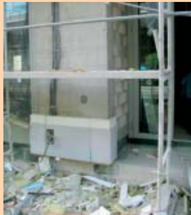
5 + 6 Versetzte Sockelelemente bei einem Neubau und der Konstruktionsaufbau.
