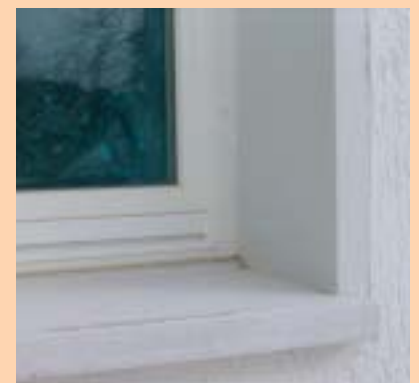
3 + 4 Die alten Betonfensterbänke wurden entfernt und neue eingebaut.
