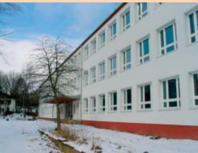
1 Schulgebäude in Wismar nach der Sanierung.
