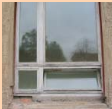
3 + 4 Die alten Betonfensterbänke wurden entfernt und neue eingebaut.
