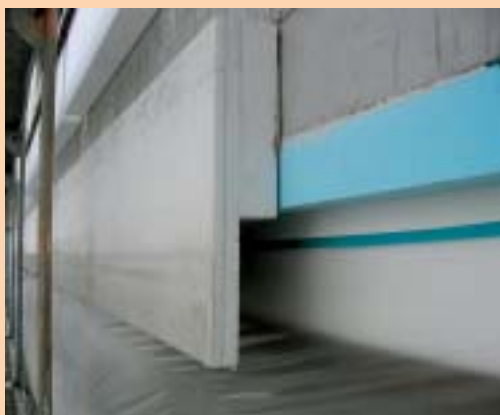
7 + 8 Versetzte Schürzenelemente bei einem Neubau und die Darstellung des Konstruktionsaufbaus. (Fotos: Maxit Deutschland)
